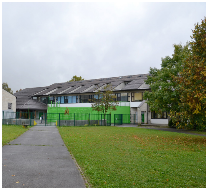
vhod na šolsko dvorišče
