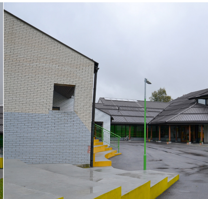
pogled protu vhodu v šolo
